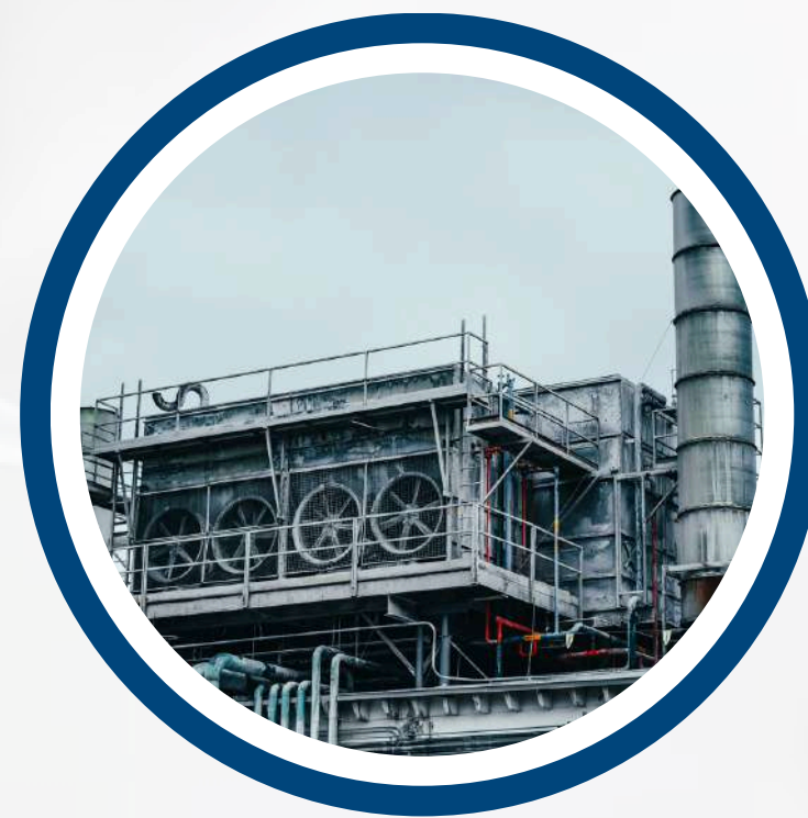
Traitement de l'eau
