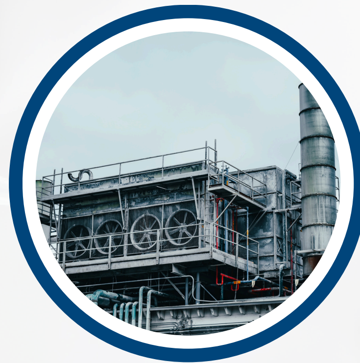
Traitement de l'eau
