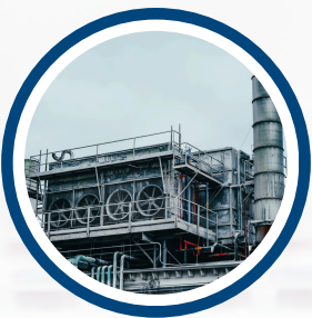
Traitement de l'eau
